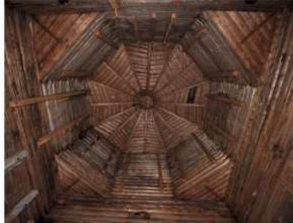
Трапезная "теплая", в ней было две печи, первоначально они топились "по черному", поэтому высота потолка в трапезной 4 метра. Вдоль стен стоят простые лавки. В центре трапезной два резных столба поддерживают матицу из пары бревен. На неё опираются пять продольных балок, по которым уложен прямой дощатый потолок. В центральном четверике устроено шестнадцатигранное "небо" с зашивкой короткими
